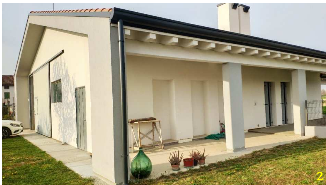
Vista lato Sud con il portico su colonne
