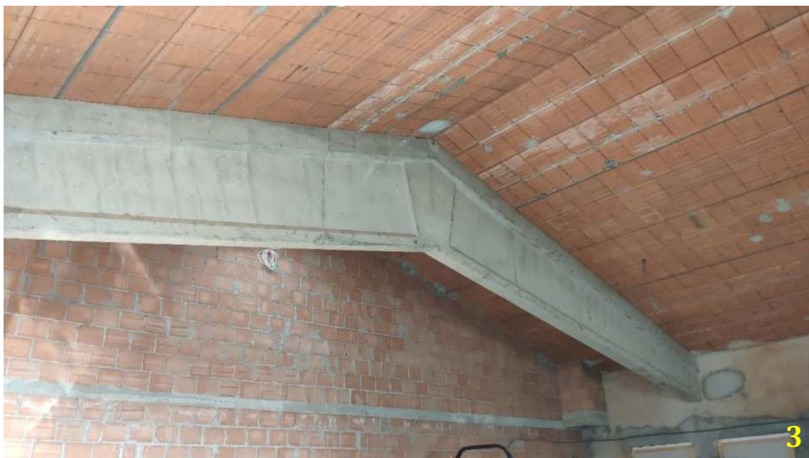
Particolare della struttura di copertura
