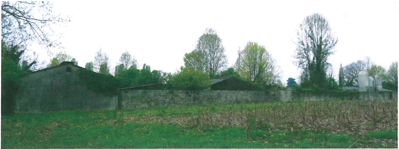
Ripresa fotografica dell'area interessata dai manufatti agricoli non più utilizzati - lato Est.
