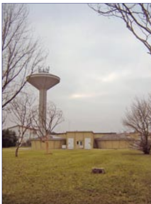
Acquedotto comunale: il serbatoio di via degli Aceri
